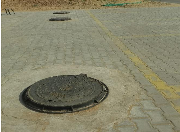
化粪池排放口
